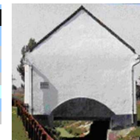
Vízi vágóhíd épülete
